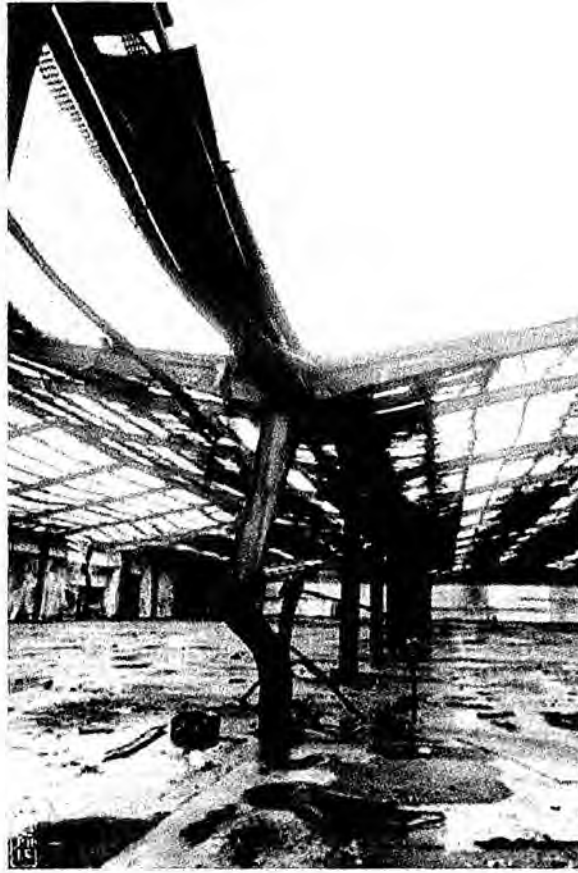
Figure 491. Buckled column, http://sophks.maze.free.fr/lab2/pct/baud4.jpg
