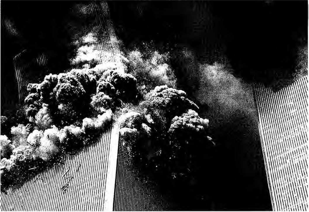
Figure 496. WTC2 Tipping top. http://www.waarheid911.nl/wtc2collapse.jpg
